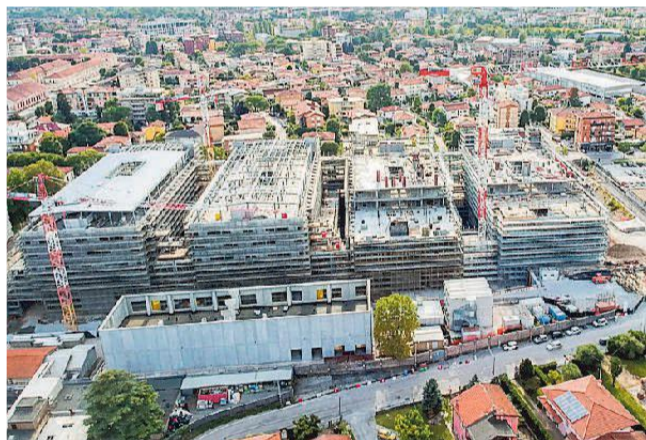
Il cantiere del nuovo ospedale di Pordenone FOTO MISSINATO
